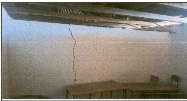
Foto 5: Reparación de pared
