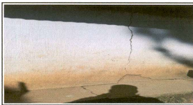
Foto 6: Reparación de pared
